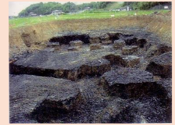
東海環状自動車道建設現場
