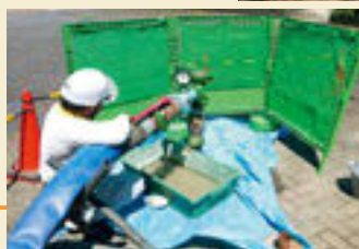
採掘跡の空洞充填作業
