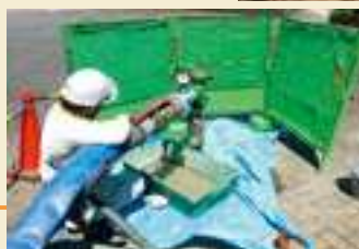
採掘跡の空洞充填作業
