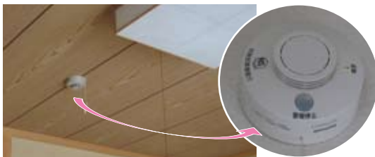
▲ 天井に設置されている住宅用火災警報器
