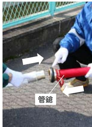
⑤ 管銃部分を2人でしっかりと持ち、放水したい方向に向けます。準備が完了したら、消火栓を開けるよう指示してください。開閉器を消火栓の凸部に合わせ、左向きにゆっくりと回します。
