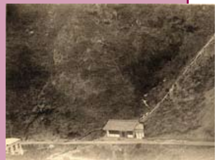
▲ コンクリート水圧管と発電機械室
