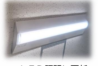
LED照明に更新
