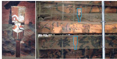
▲ 壁面に打ち付けられた羽子板 ▲
