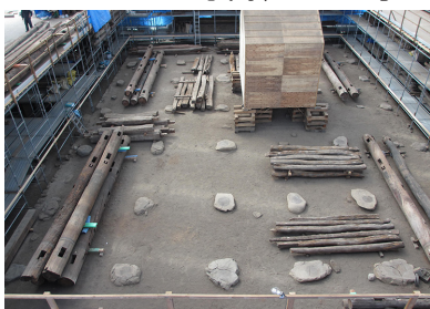
▲解体が完了した本堂（令和3年4月）
