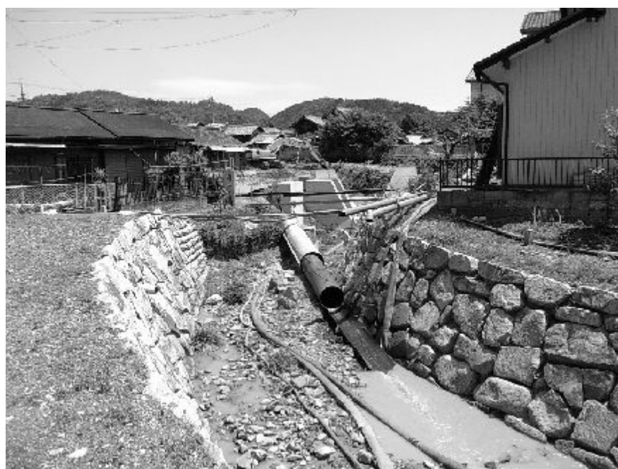
唐沢川上流河川改修工事の様子（５月調査）
