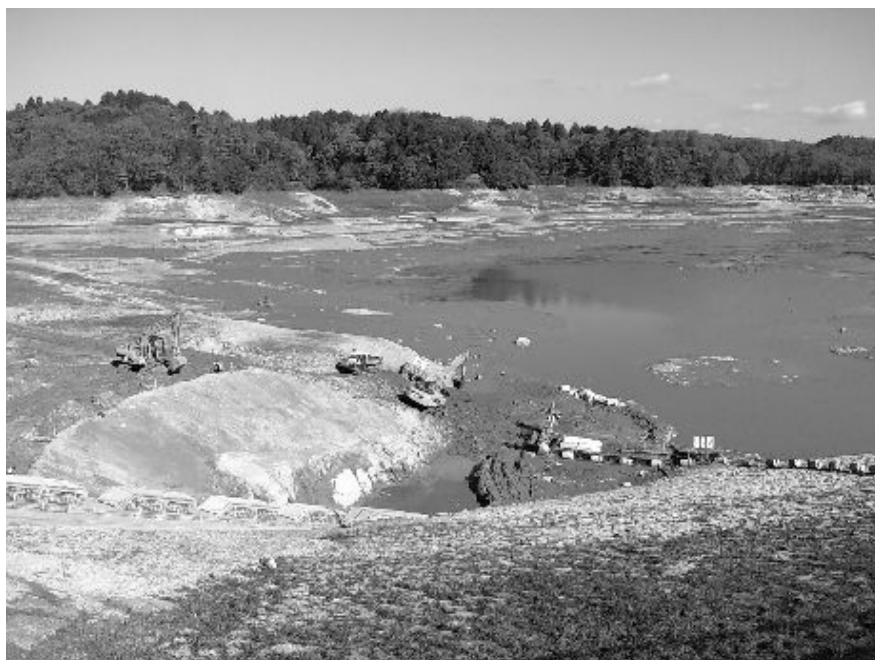
松野湖浚渫工事の様子（12月調査）
