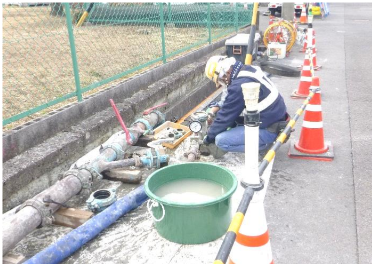
亜炭鉱跡防災工事の様子
