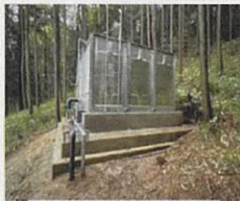
増設した給水槽
