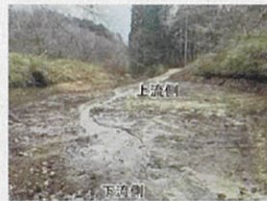
神田川堰堤付近浚渫後の状況(3/25)
