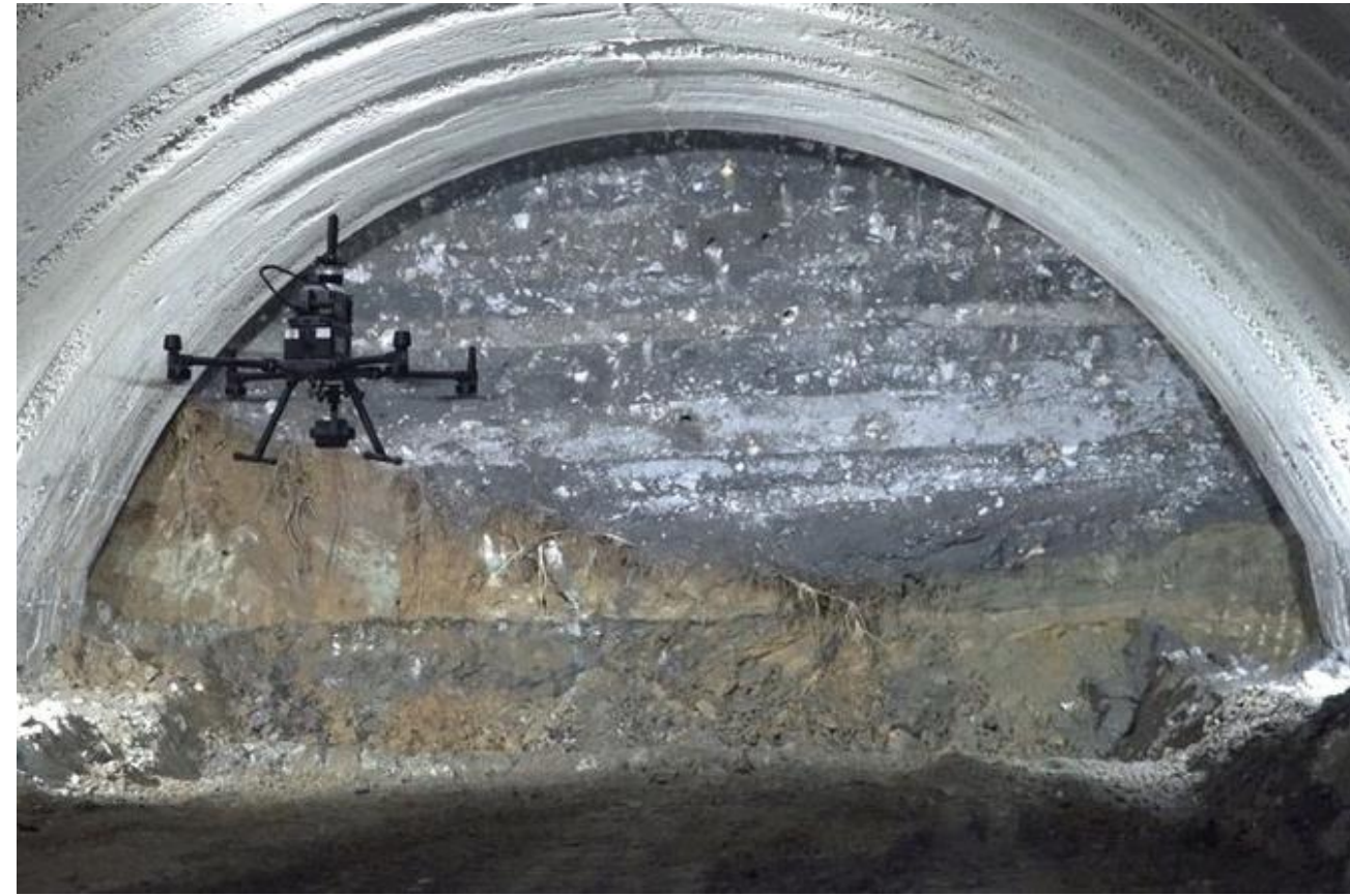
地層の境（おそらく坑口付近）
