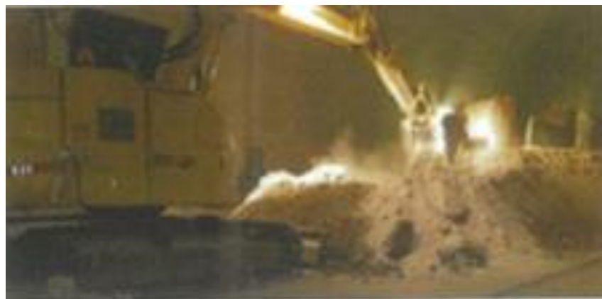
白鳥トンネル坑内不溶化処理状況
