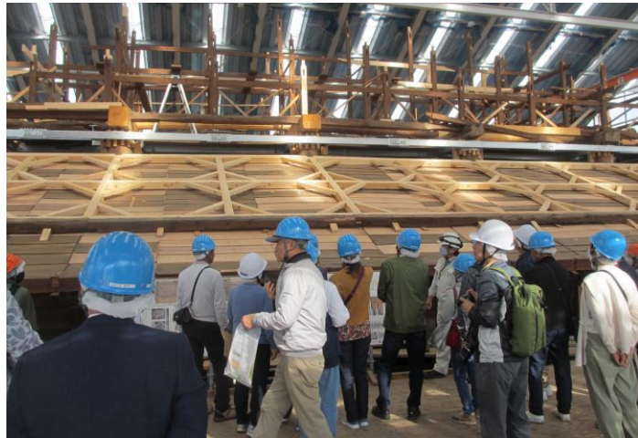
▲11/17 願興寺本堂修理工事現場見学会
