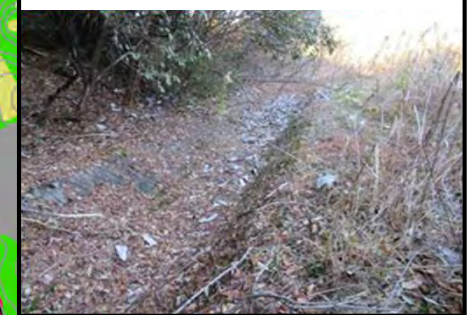
写真① 既設の盛土
