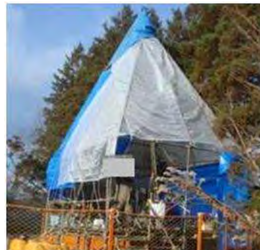
ボーリング調査の実施
