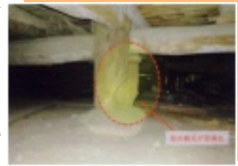
▲柱の足元の状況
