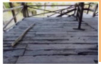
▲本堂の床板の状況
