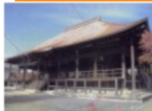
▲本堂屋根の状況
