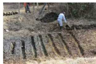
土砂堆積部分の浚渫
