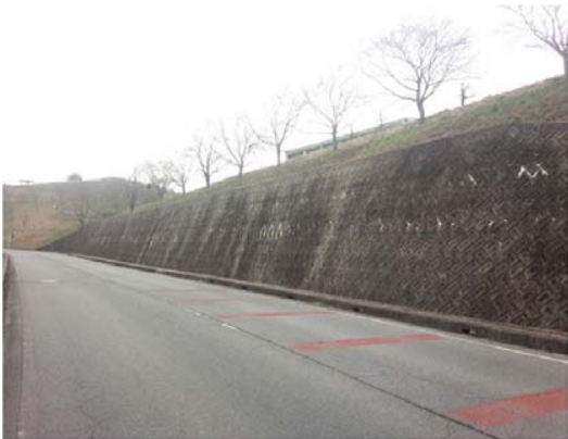
写真 ③ 盛土端部(ブロック積擁壁) 変状は認められない。
