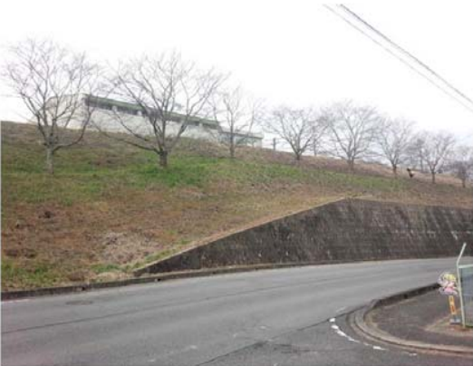
写真 ④ 盛土端部(ブロック積擁壁) 変状は認められない。
