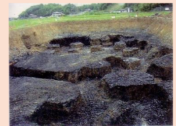
東海環状自動車道建設現場
