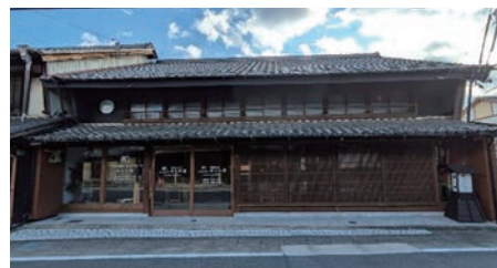
▲旧旅籠柏屋主屋の外観
