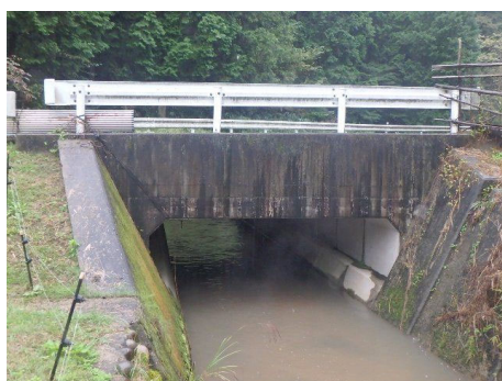
溝橋（新木野 2 号橋）
