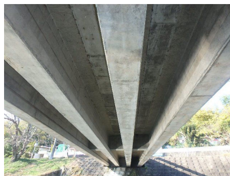
PC 橋（野崎橋）
