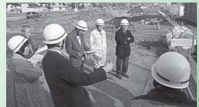
国道21号バイパス工事現地視察
