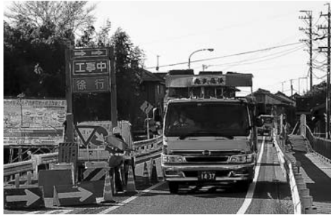
国道21号現道改良工事（伏見・東坂 H22年1月）
