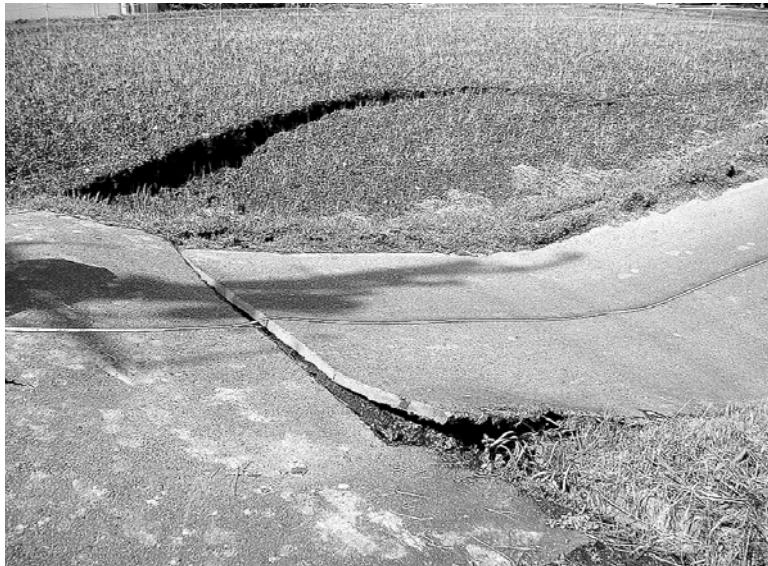
平成21年5月に中(長瀬)地内の町道、田で発生した陥没(10月に復旧済)
