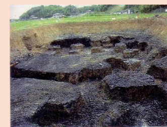
東海環状自動車道建設現場
