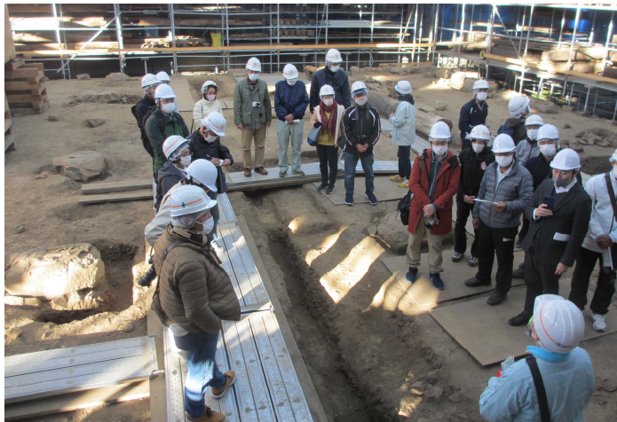
▲11/28 願興寺本堂修理工事現場見学会
