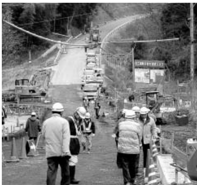
整備が進む資材運搬線（網木地内）
