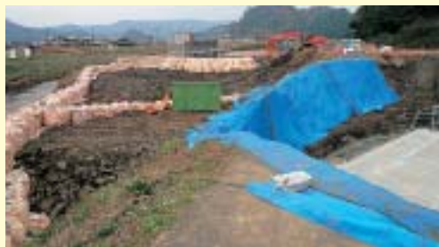
仮称・可児川橋建設箇所（木下地内）
