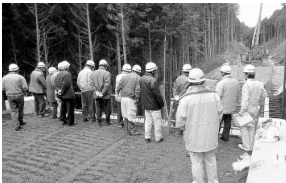
整備が進む資材運搬線（前沢地内）
