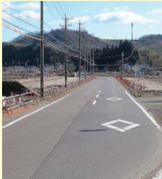
整備が進む二十一号バイパス（尼ヶ池地内）
