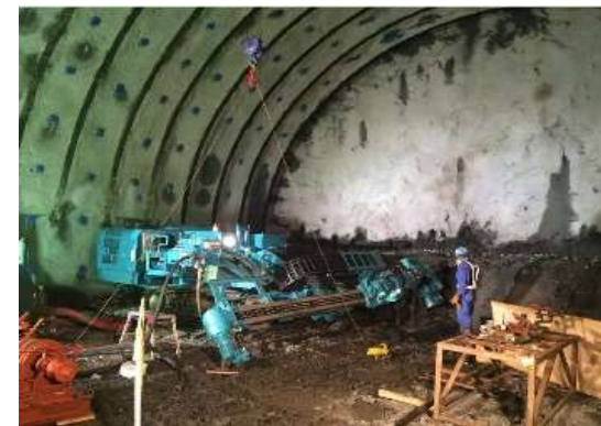
先進ボーリング
