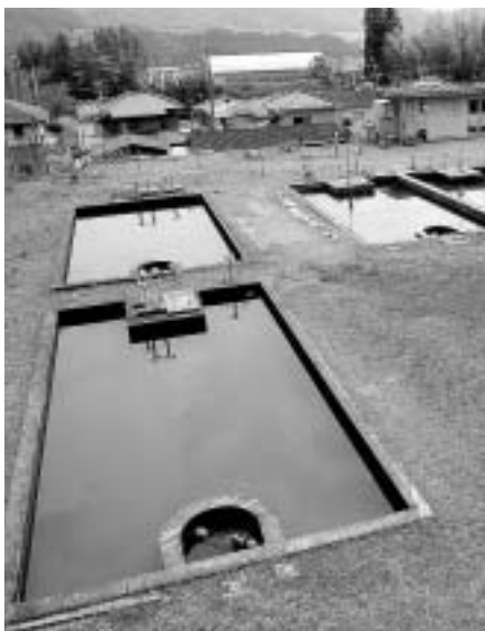
赤坂の浄水場
