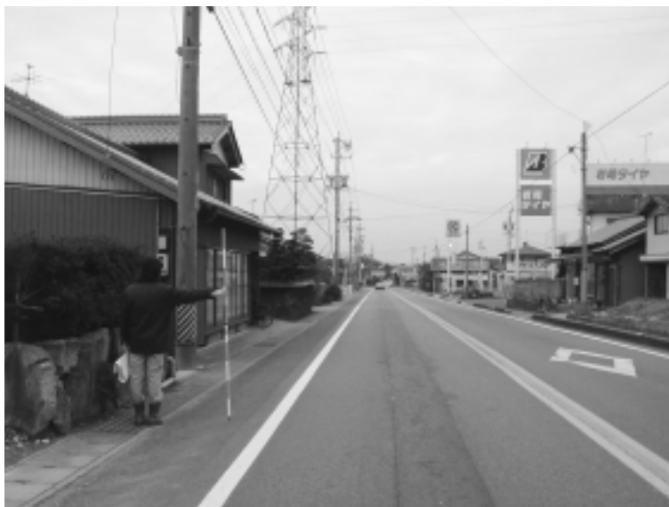
下水整備される大庭地内(中地内)
