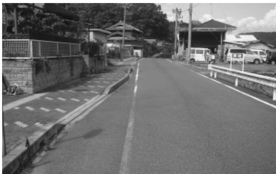
下水整備される山田地内(伏見地内)
