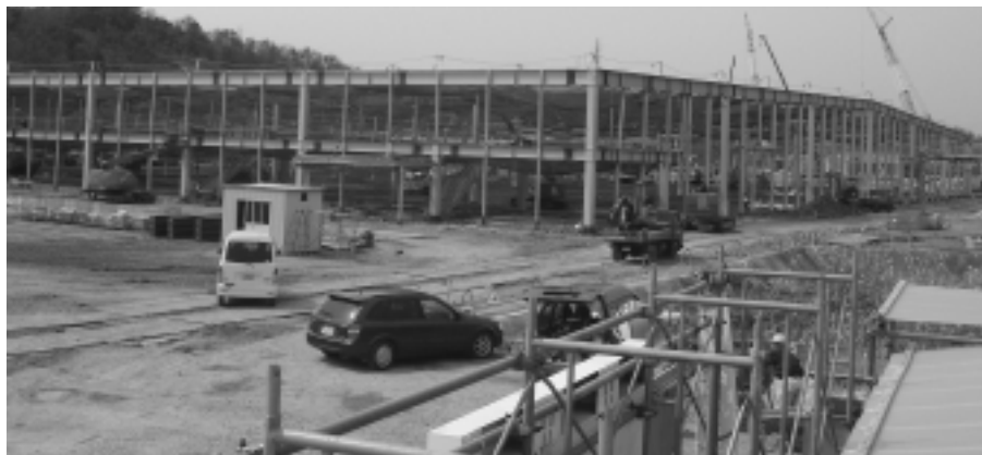
完売となり、次々に工場が立地・操業開始されている「グリーンテクノみたけ」
