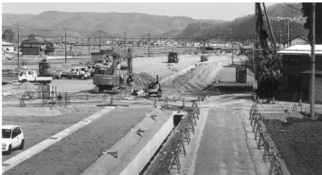
早期全線開通が望まれる国道21号バイパス
