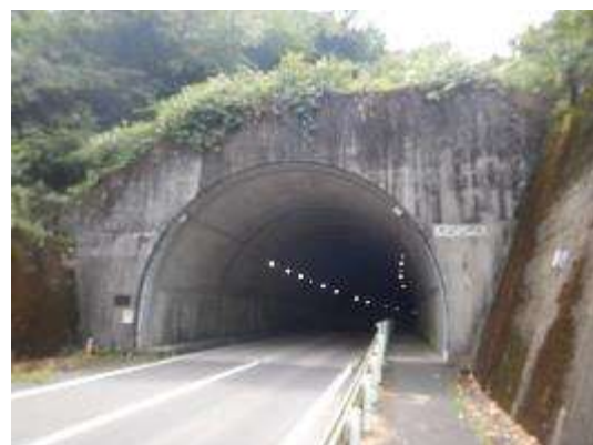
写真 2-2 南山トンネル終点側坑口
