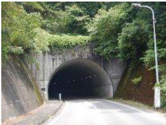
写真 2-1 南山トンネル起点側坑口
