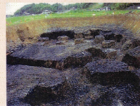
東海環状自動車道建設現場
