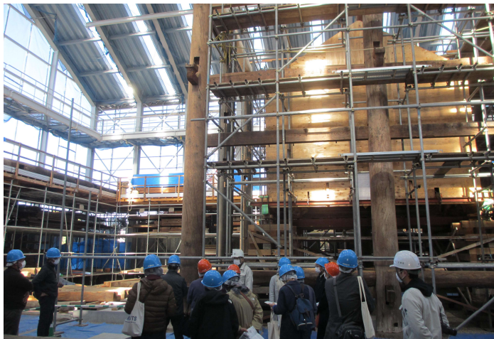
▲11/27 願興寺本堂修理工事現場見学会
