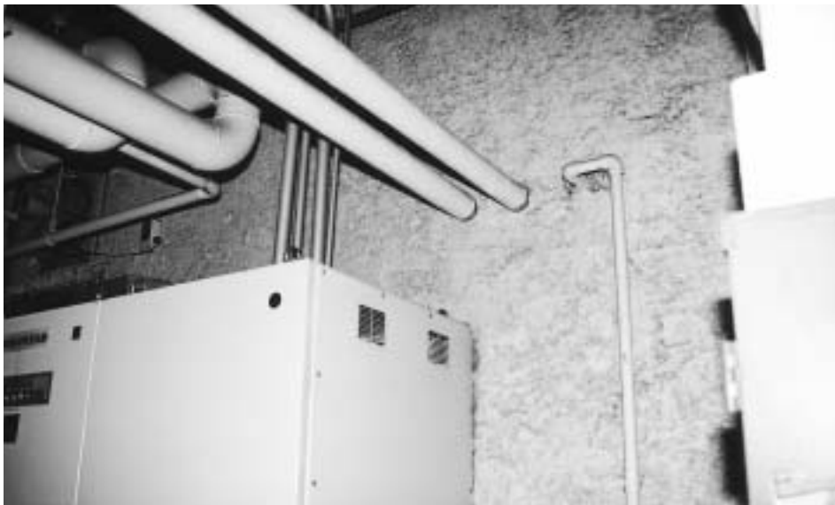
役場本庁舎機械室の壁面に吹き付けられているアスベスト
