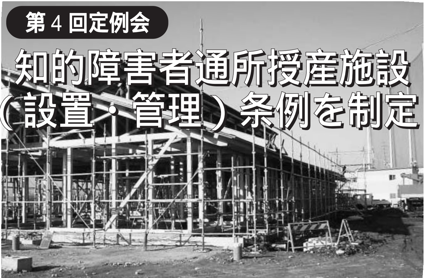
【顔戸八幡神社の東に建設中の新施設「みたけ共同作業所」】
