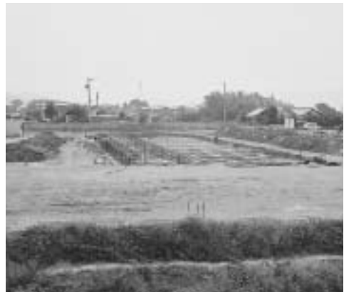
障害者福祉施設建設用地
