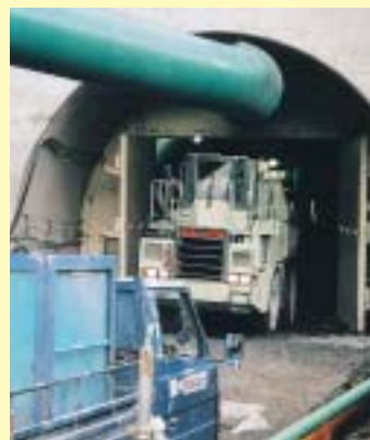
着々と工事が進む「大久後トンネル」
