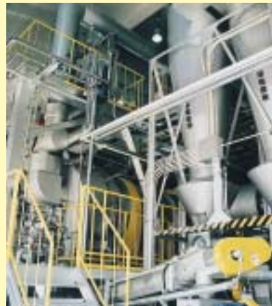
本年4月に竣工した「汚泥再生処理施設」
