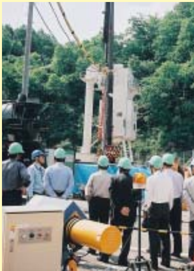
立坑の掘削の様子（瑞浪超深地層研究所）
