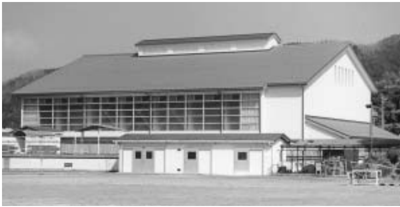
新しくなった上之郷中学校体育館（平成14年度竣工）
