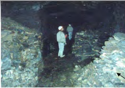
(b) 坑道と積み上げられたはさみ (ぼた)
