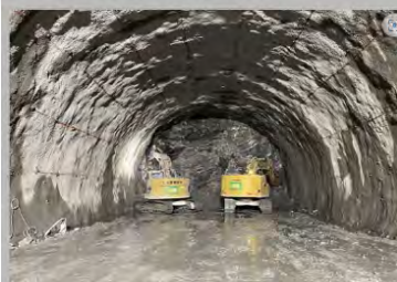
第一中京圏トンネル：西尾工区（令和3年6月）
