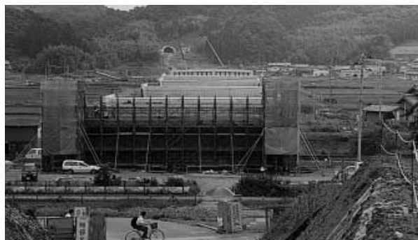
建設中の東海環状自動車道
