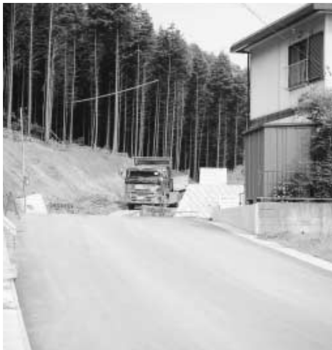
赤坂・板良地区避難路新設工事
