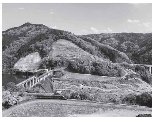
新丸山ダム建設工事現場
