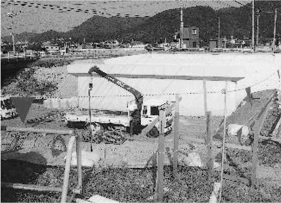
新川橋架替工事
