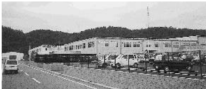
操業している各工場
