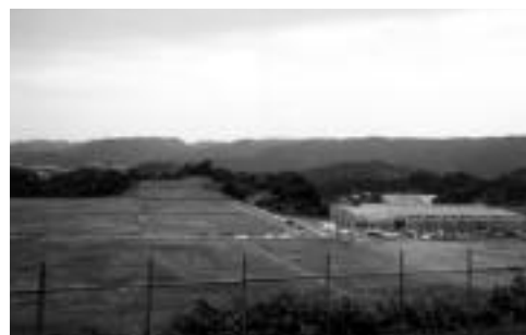
建設中の工場と広い敷地
