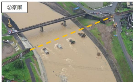
平成 29 年 7 月九州北部豪雨（JR 久大線花月川橋梁が流失）
