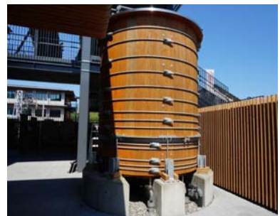
【受水槽の設置/四万十町】
