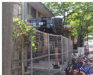
【自家発電装置/宮代町】
