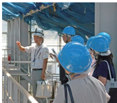
▲講座①『御嵩を知る』 願興寺本堂（国重要文化財）の保存修理工事現場を見学しました。
