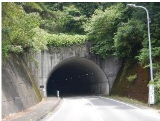
写真 2-1 南山トンネル起点側坑口
