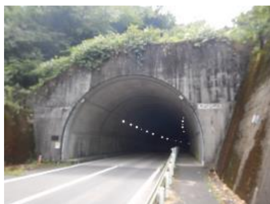
写真 2-2 南山トンネル終点側坑口
