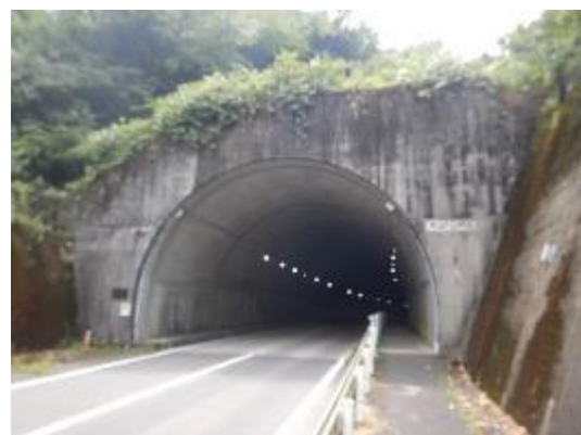
写真 2-2 南山トンネル終点側坑口
