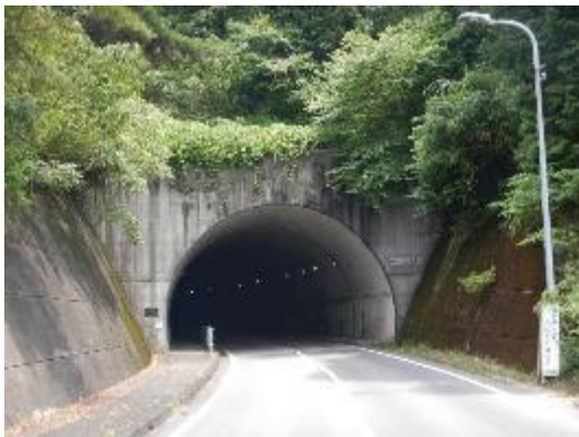
写真 2-1 南山トンネル起点側坑口
