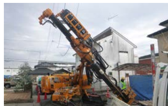
▲削孔工事のようす
