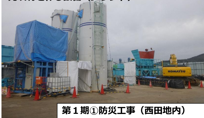
充填材を作る設備（プラント）
